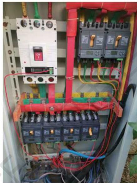
电缆分接箱进、出线开关安装图
